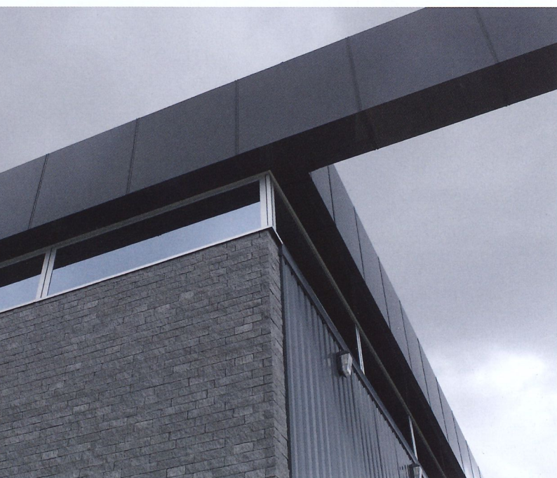
Stootvoegloos bakstenen gevelmetselwerk in wildverband, met verdiepte voegen.
