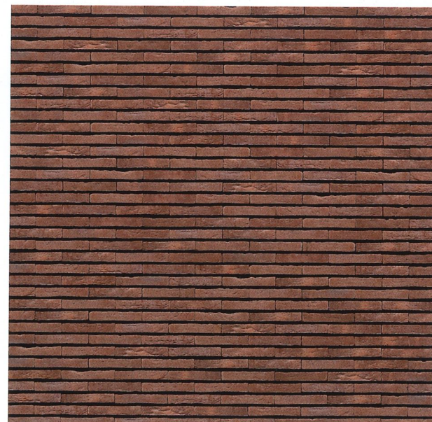
Foto links Stootvoegloos bakstenen gevelmetselwerk met handvorm bakstenen Omega in halfsteensverband met verdiepte lintvoegen.
