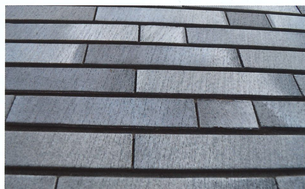
Stootvoegloos bakstenen gevelmetselwerk in wildverband, met verdiepte voegen.
