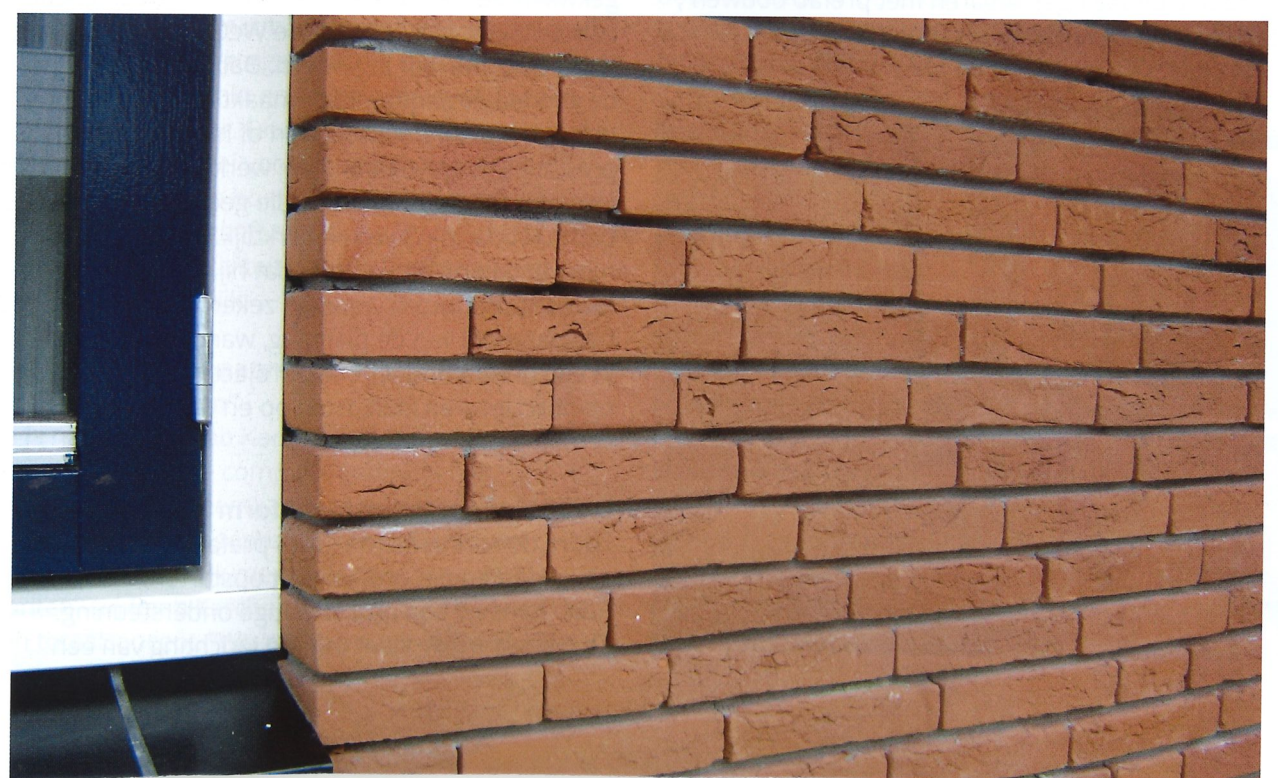
Stootvoegloos bakstenen gevelmetselwerk met handvorm bakstenen in wildverband en verdiepte lintvoegen.
