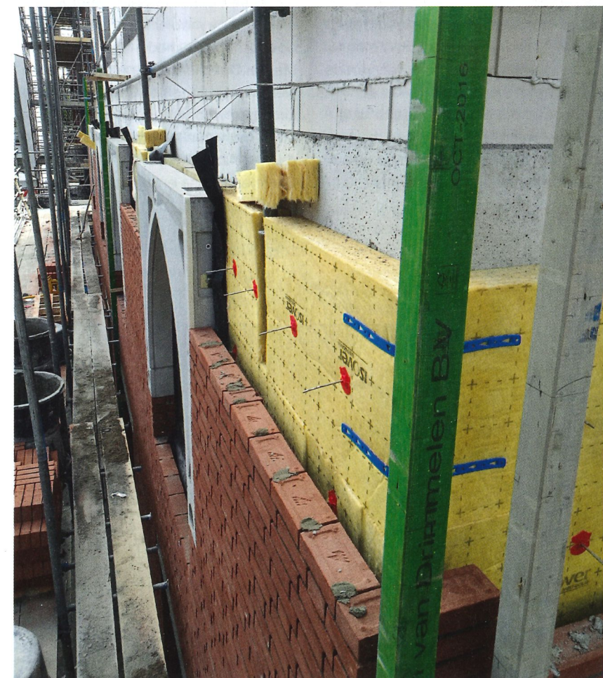
Goed voorbeeld van een spouwmuur met voldoende luchtspouw, zoals het hoort.
